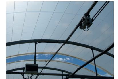
Separación de las lonas mediante cable y torno
