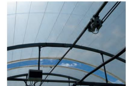
Folienraffung mit Kabelsteuerung und mechanischer Winde
