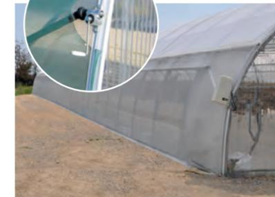
Durchgehende Seitenlüftung durch Folienaufrollung
