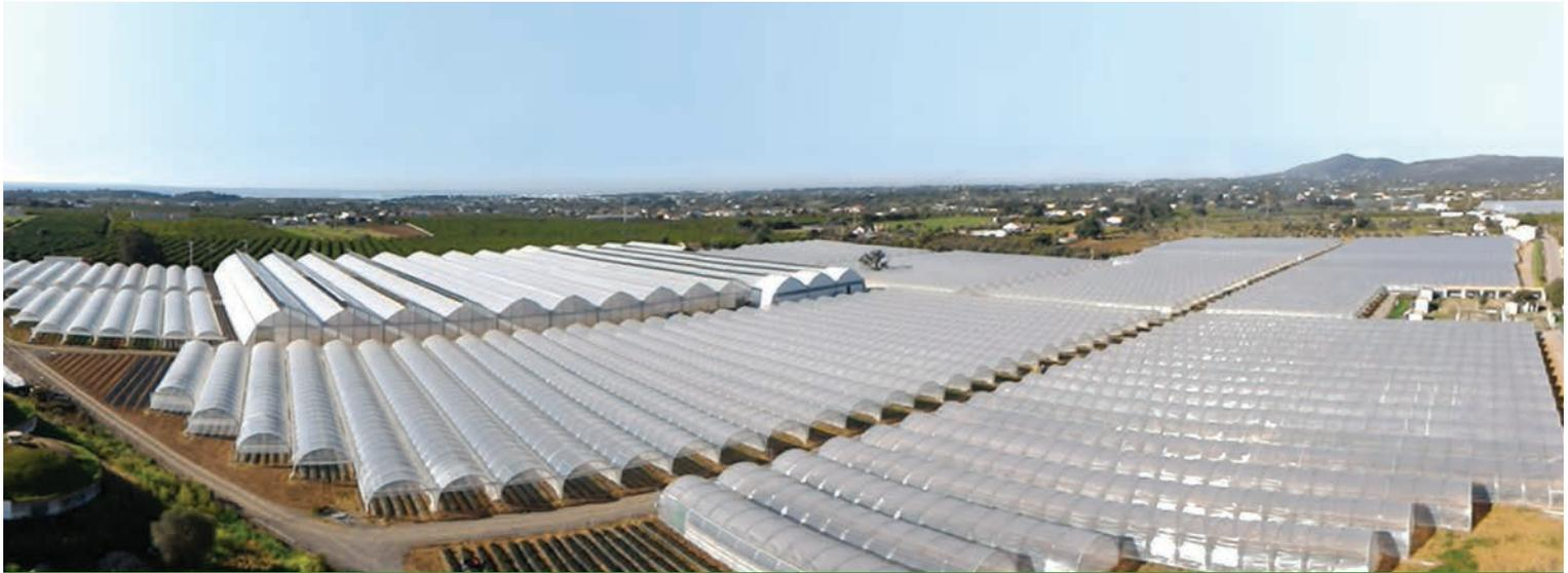
Die 6,20 m und 8,50 m breiten Multitunnel von RICHEL sind eine einfache und preiswerte Antwort auf die Bedürfnisse der Produzenten von Beerenfrüchten. Die Technik und Qualität der neuen RICHEL Multitunnelserie überzeugt bereits bei anderen Produktreihen wie Tunneln und Blockbauweise.
