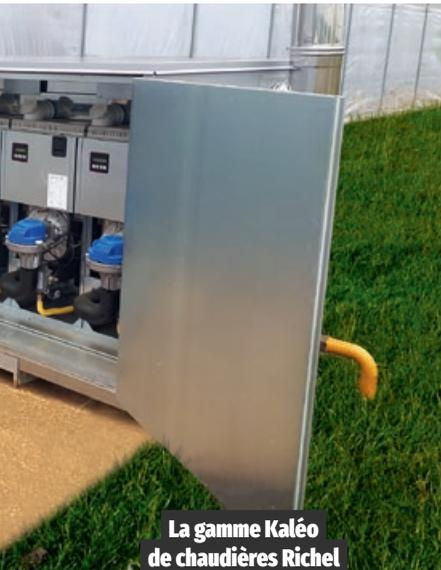
**La gamme Kaléo de chaudières Richel basse température, peut être installée à l'intérieur ou à l'extérieur de la serre.**
